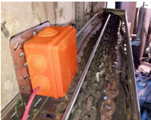
Примеры крепления монтажных коробок
