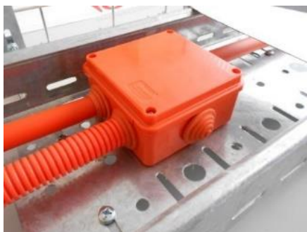
Пример соединения монтажной коробки с гофрированной трубой
