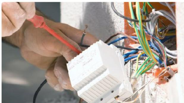
Контактная отвертка-индикатор Navigator серии NHT-0ti01 предназначена для проверки наличия переменного напряжения в сети, определения контакта «фаза/ноль».
