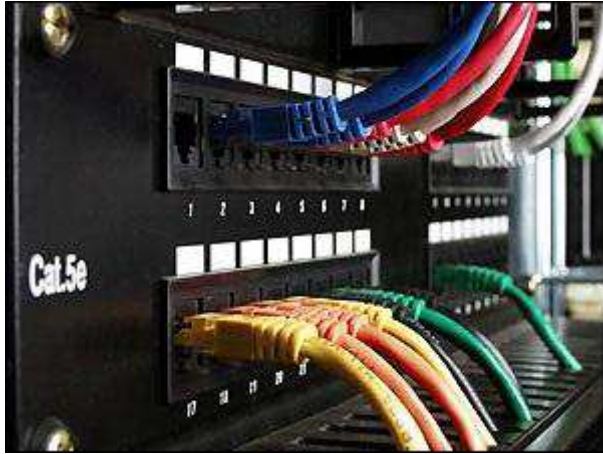
Патч-панель категории 5е с подключенными патч-кордами
